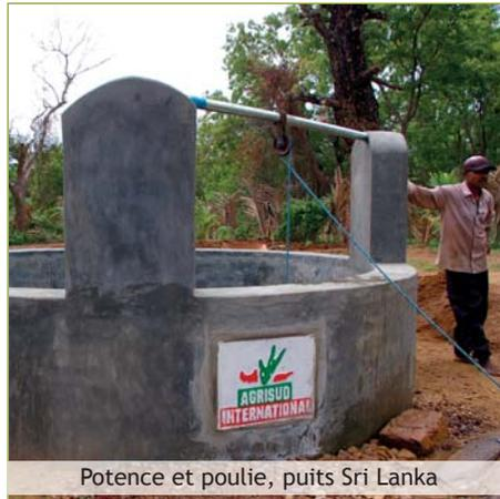
Potence et poulie, puits Sri Lanka
